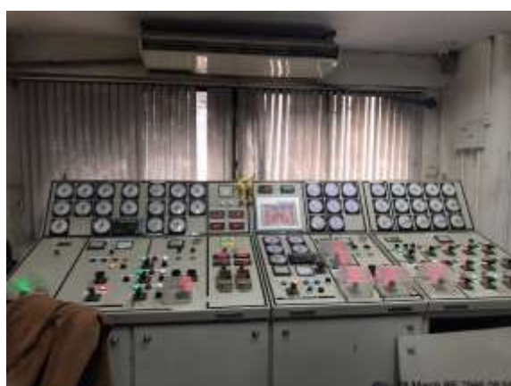
ระบบควบคุมเครื่องกำเนิดไฟฟ้า
