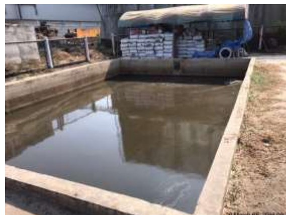
รูปที่ 15 บ่อพักน้ำทิ้งคอนกรีตรองรับน้ำทิ้ง จากหม้อไอน้ำ
