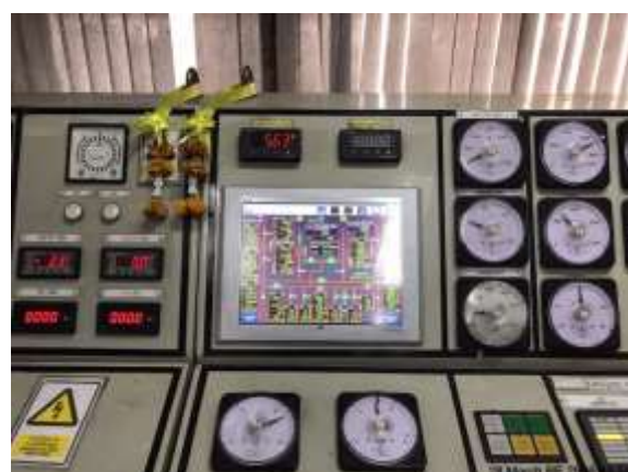
ระบบควบคุมเครื่องกำเนิดไฟฟ้า
